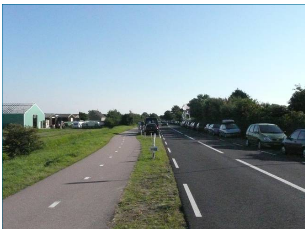
Afbeelding 34: Bestaande ligging fietspad langs het Zwanenwater naast de Duinweg
