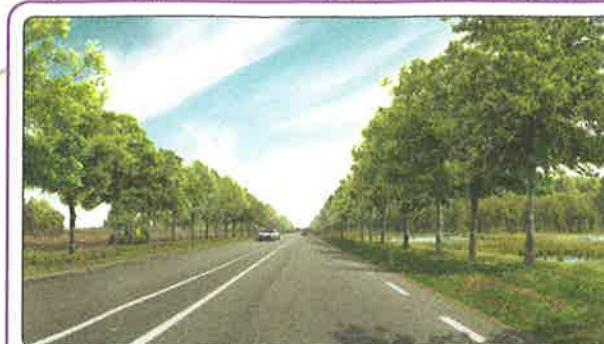
Ligging N69 parallel aan Keersoppedreef (richt richting oorden)
