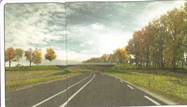
Passage onder Broekhovenweg richting noorden
