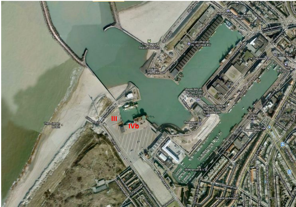
De tijdelijke vestiging van het dans- en muziektheater bestaat uit twee delen, te weten het Speelhuis (de theaterzaal) en het Woonhuis (de ondersteunende faciliteiten, zoals kantoren en oefenruimtes). Het Speelhuis is voorzien op blok III van het Stedenbouwkundig plan, het Woonhuis op blok IVb.
