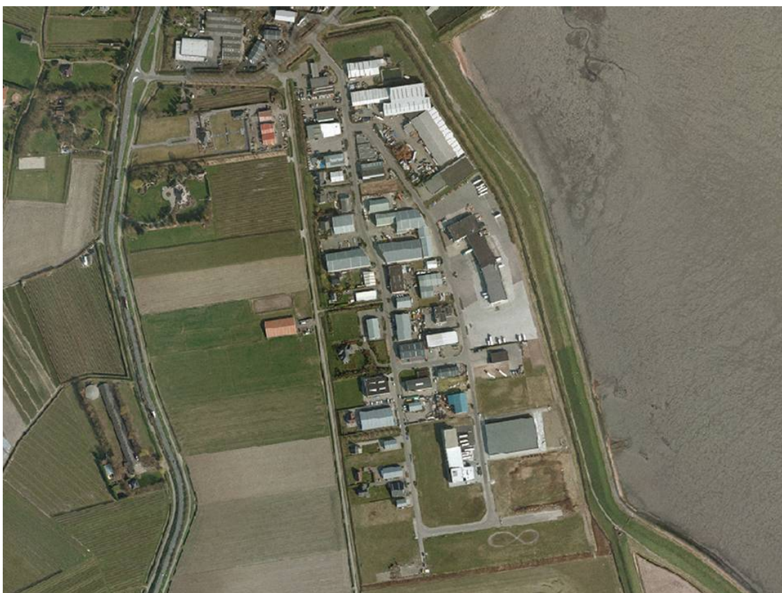
Figuur 3.3. Bedrijventerrein Olzendepolder
