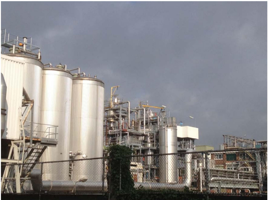
Croda binnendijks, ter hoogte van de leidingbrug over de Rotterdamseweg
