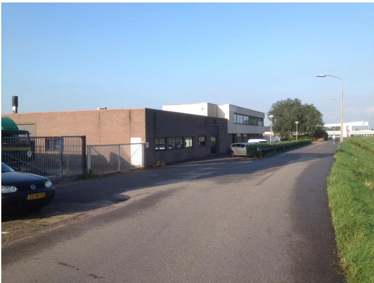
Zicht op de westpunt van de Schielands Hoge Zeedijk
