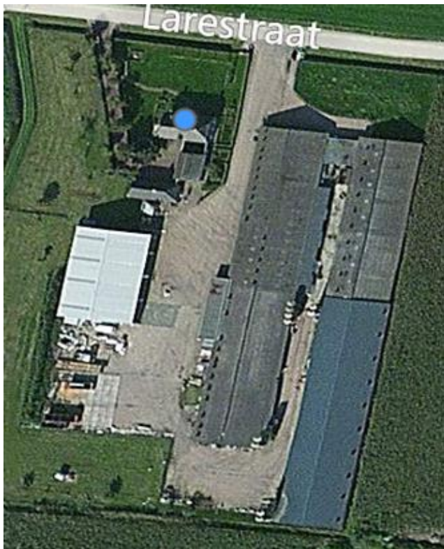
Figuur 7.2.1.1: foto bestaande situatie Larestraat 2a
