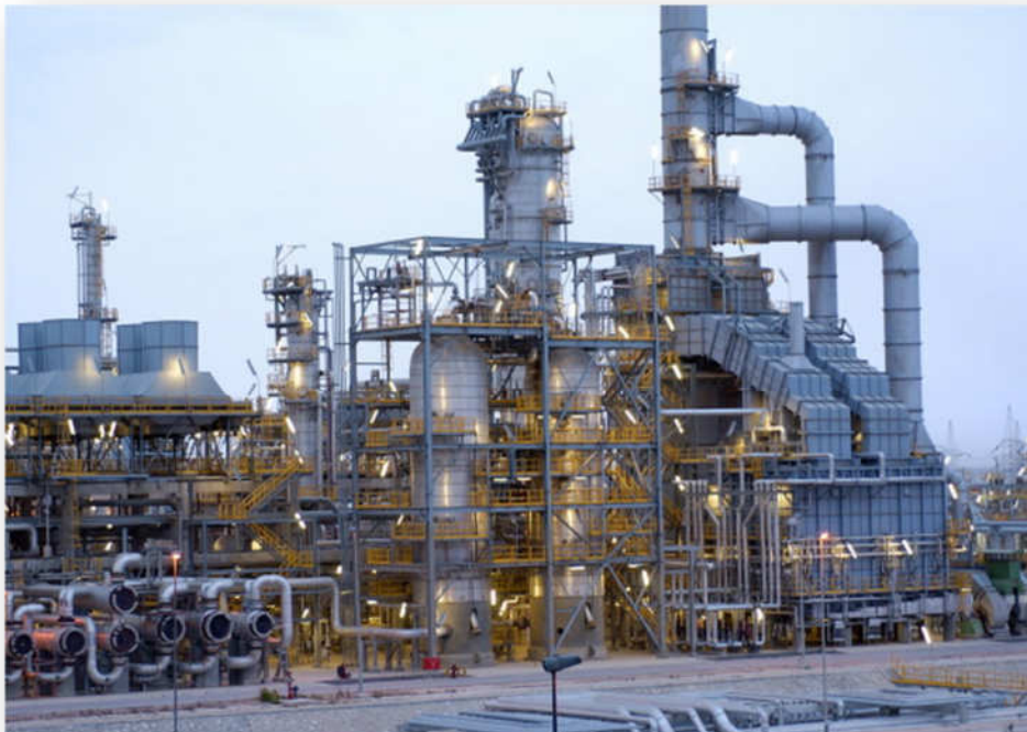
Figuur 3.1: Impressie van een Lube Oil Hydrocracker
