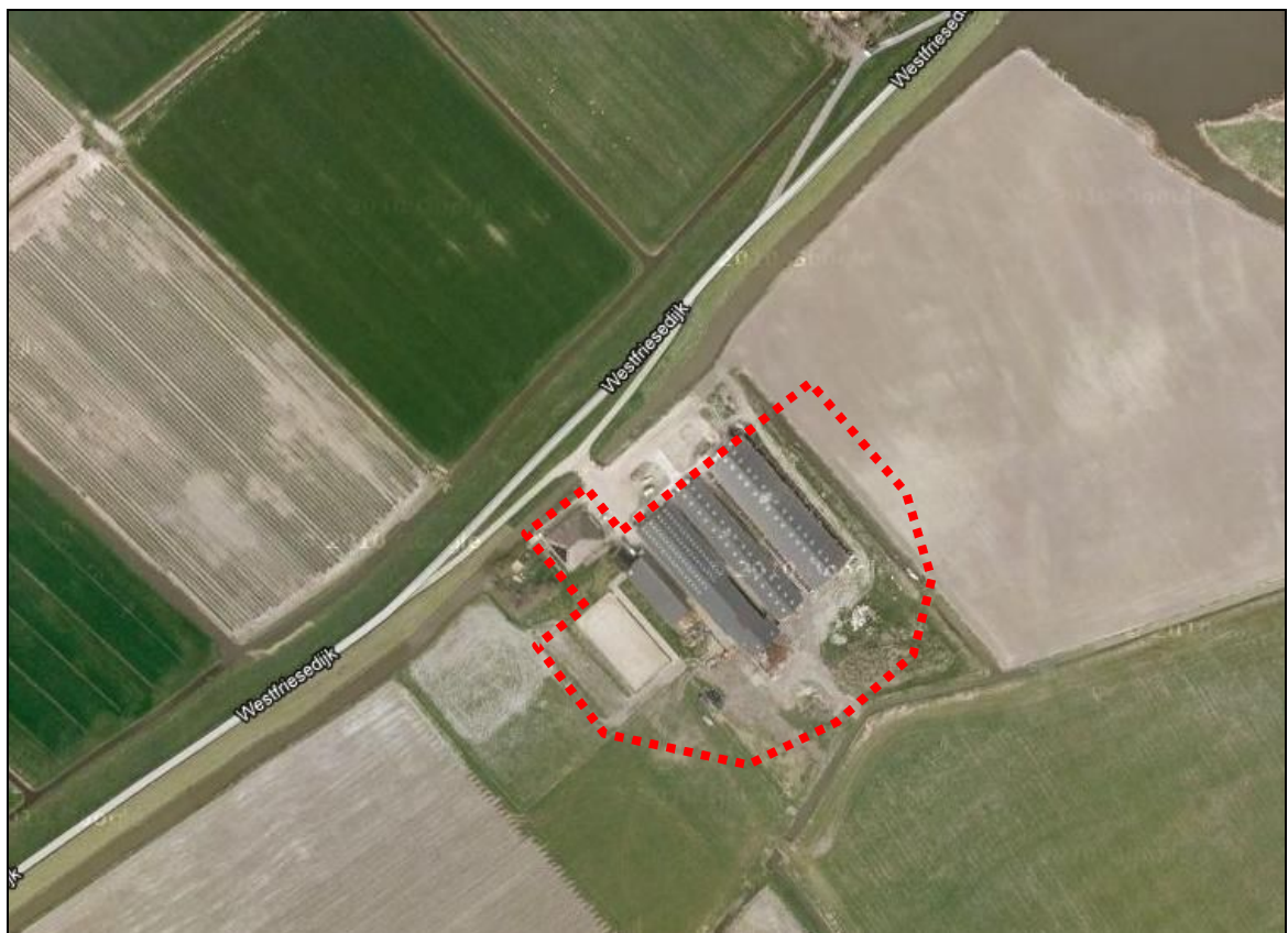
Afbeelding 1. Satellietfoto met daarop de ligging van het plangebied in rood. (Bron: maps.google.nl)
