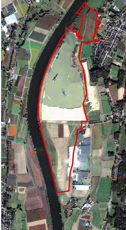
Figuur 5.17 Luchtfoto van de in aanleg zijnde hoogwatergeul Lomm (situatie november 2012)
