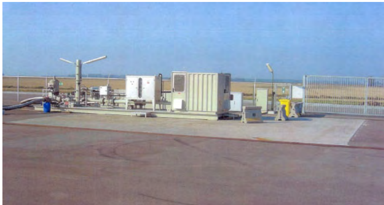
Figuur 4.4: Productieskid (KISS-skid, voorbeeld)
