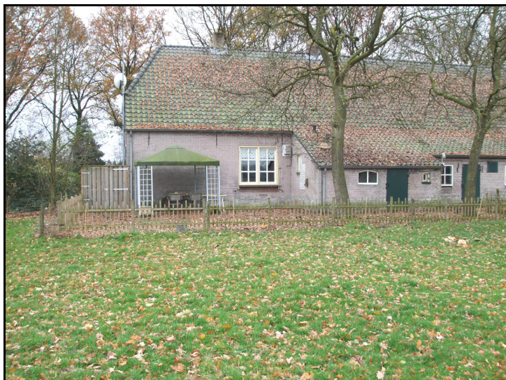
Figuur 10 Achterzijde bestaande woning
