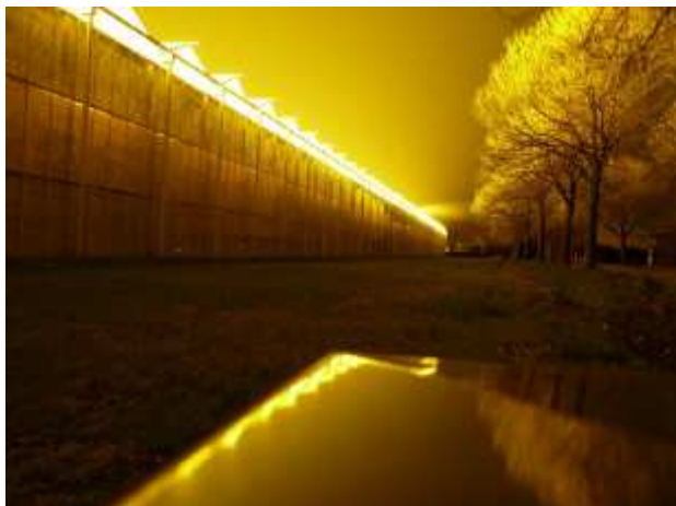
lichtemissie uit kas zonder bovenafscherming
