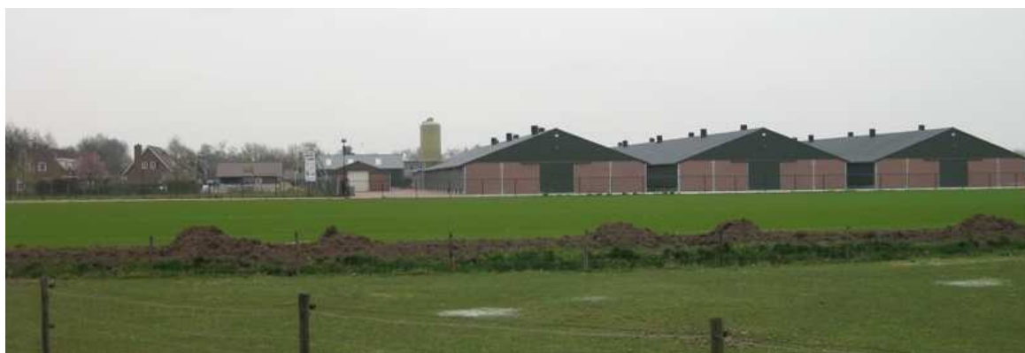
Figuur 10. Huidige situatie plangebied aan de Zandstraat 99.
