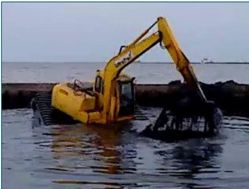
Figuur S2.9 Backhoe aan het werk
