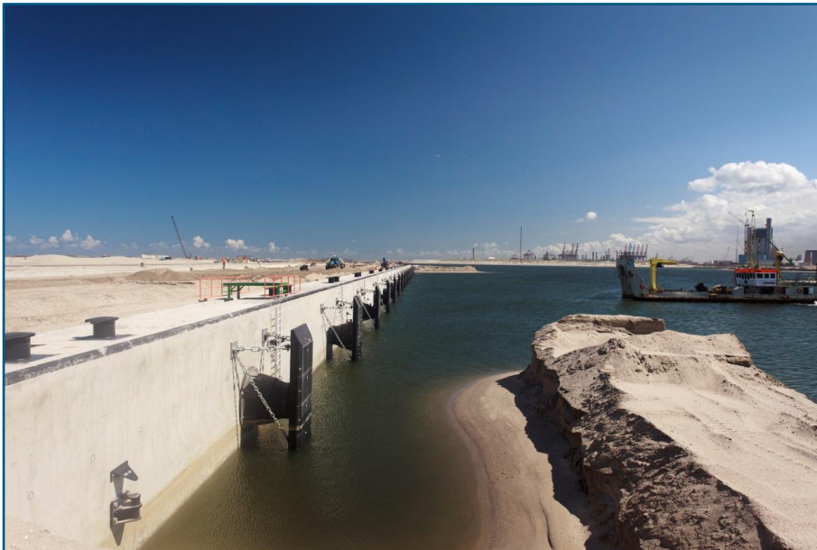
Figuur S2.2 Aanleg van een zeekademuur
