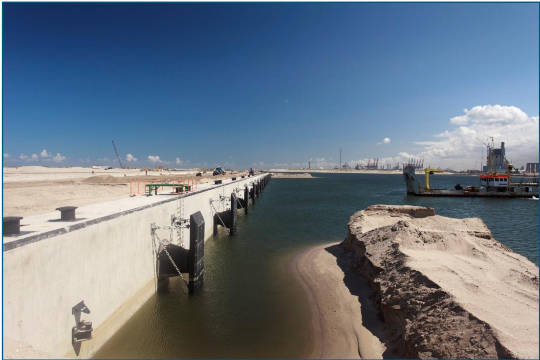
Figuur 2.5 Aanleg van een zeekademuur
