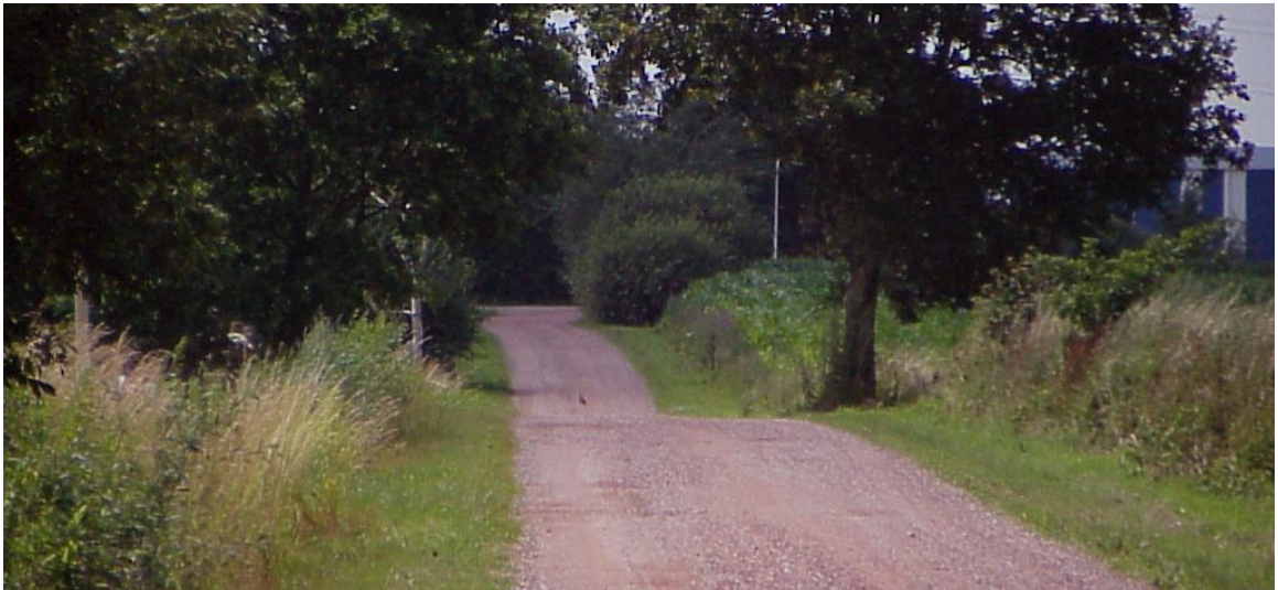
Figuur 2.2: Verzakking aan het maaiveld aan de Boekeloseveldweg.
