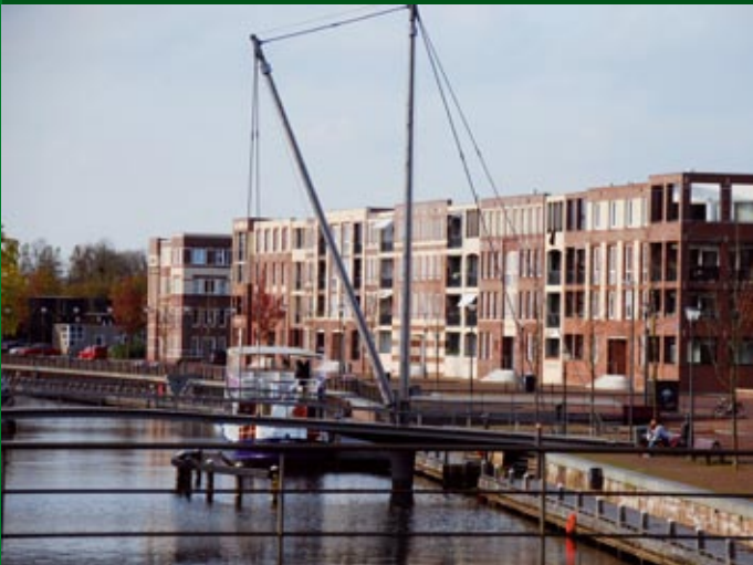
Centrum Amersfoort na transformatie
