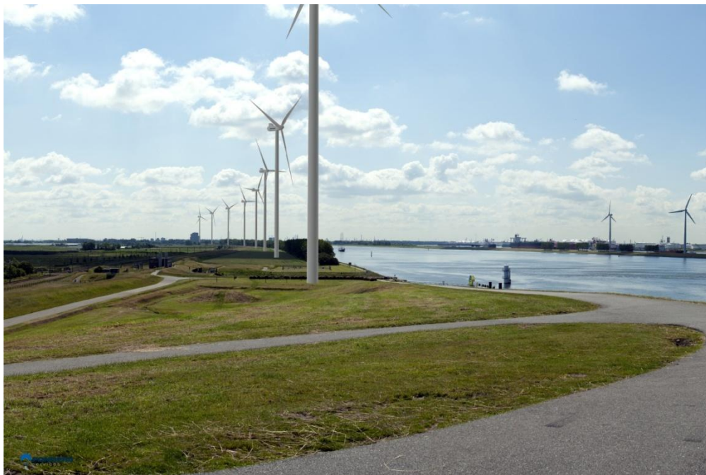
Alternatief 2 – 9x V112 3 MW op 119 meter ashoogte
