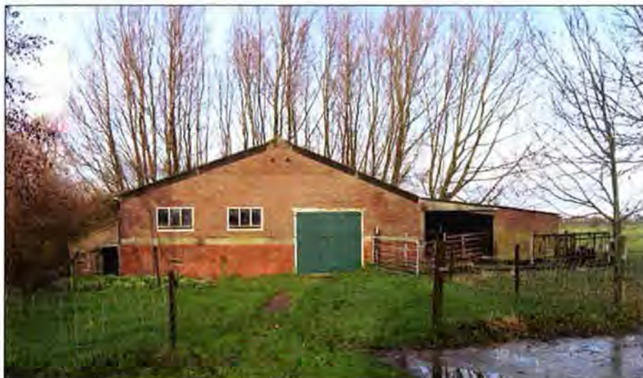
Figuur 5. Te slopen bebouwing
