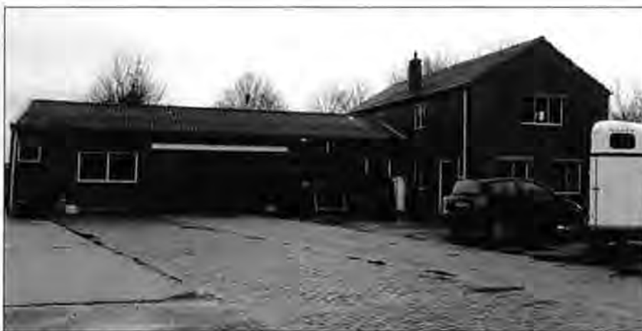
Figuur 5. Te slopen bebouwing
