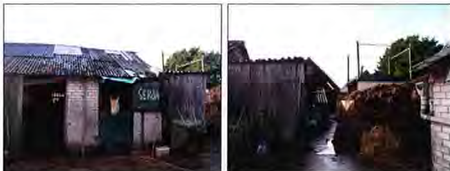
Figuur 5. Te slopen bebouwing
