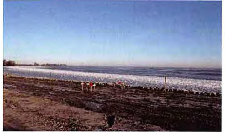
Dijkversterking tussen Enkhuizen en Hoorn.
