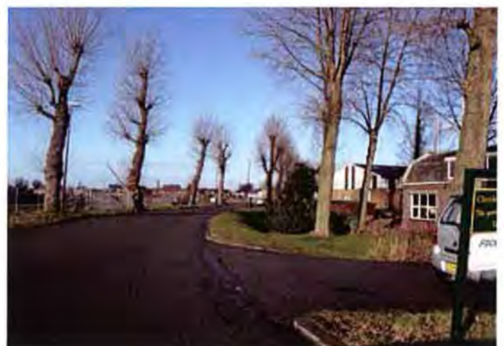
Omringdijk door industrieterrein Oudorp.
