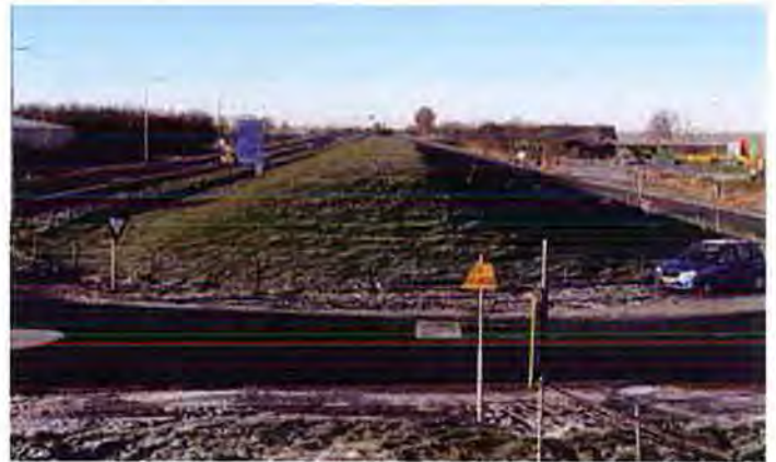
Doorsnijding van de dijk bij de Wieringermeer.
