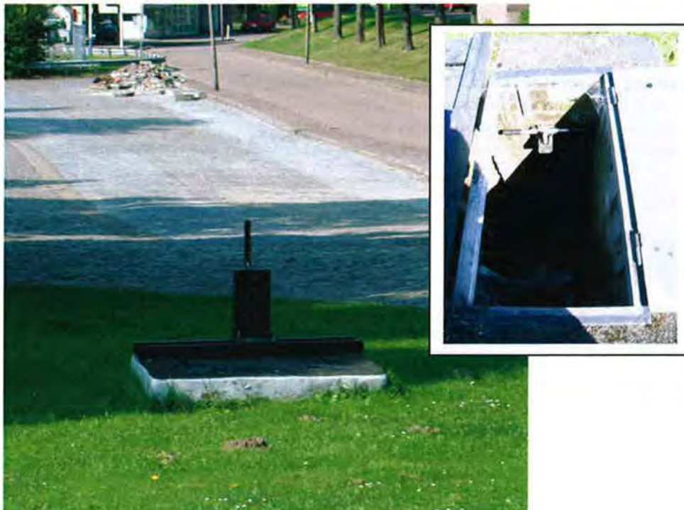
Foto 6 Bestaande inlaatsluis 's-Gravendeel (binnenberm)
