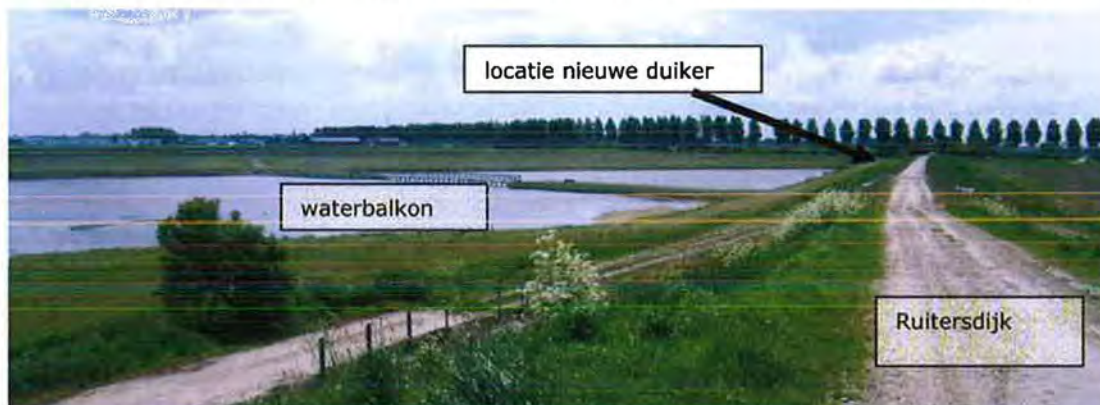
Foto 1 Locatie nieuwe duiker Ruitersdijk
