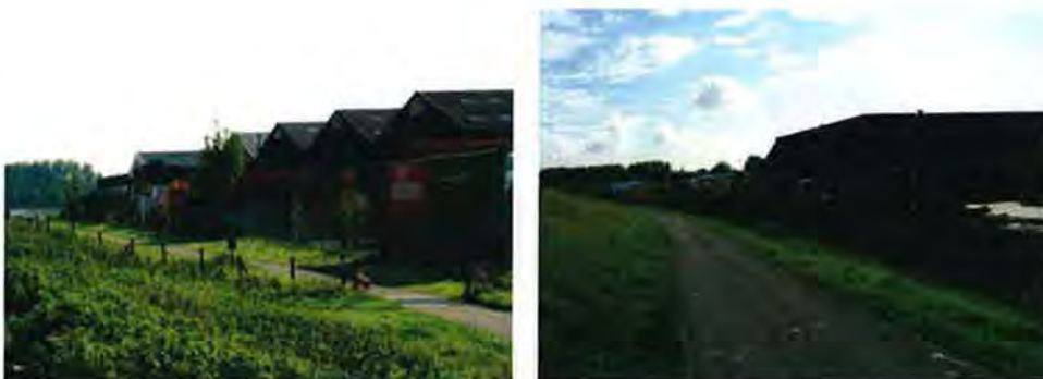
Afbeelding 34: Situatie ter hoogte van de palletfabriek
