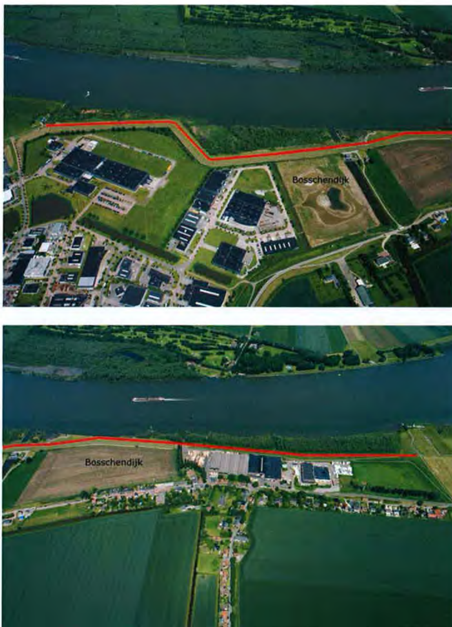
Afbeelding 8: Te versterken dijktracé Bosschendijk
