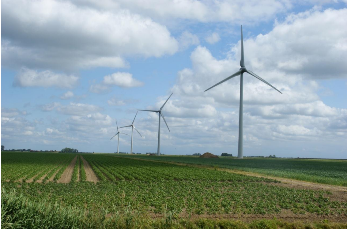
Figuur 10.7 Beeld van vier van de vijf windturbines van het windturbinepark Wisse Wind op Sint Philipsland (ashoogte 78 meter, rotordiameter 82 meter)
