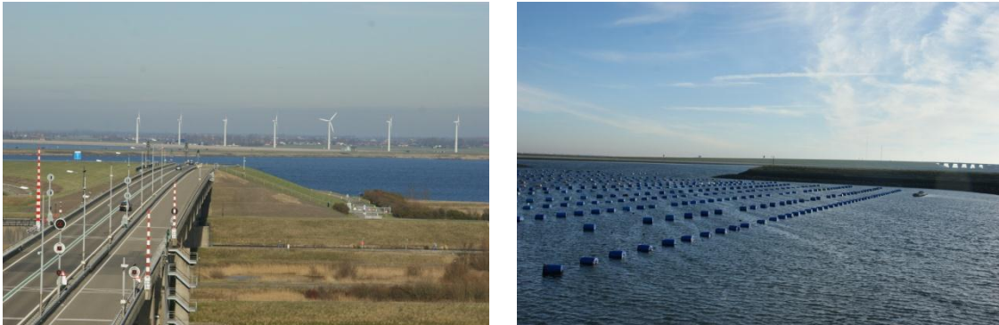
Figuur 5.9 geeft een impressie van de huidige situatie nabij en op het sluisencomplex.
