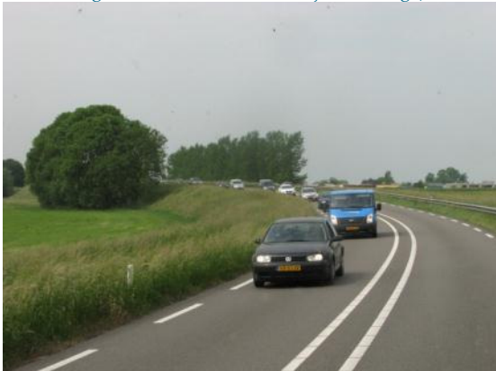
Foto 6 Brug over de Drecht, noordelijke richting (mei 2012)
