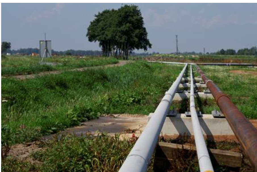
Figuur 20. Leidingtracé in aanleg
