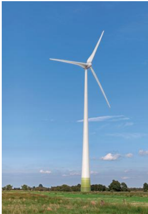
Klasse 3-5 MW (afgebeeld type: Enercon E-82; 3 MW)
