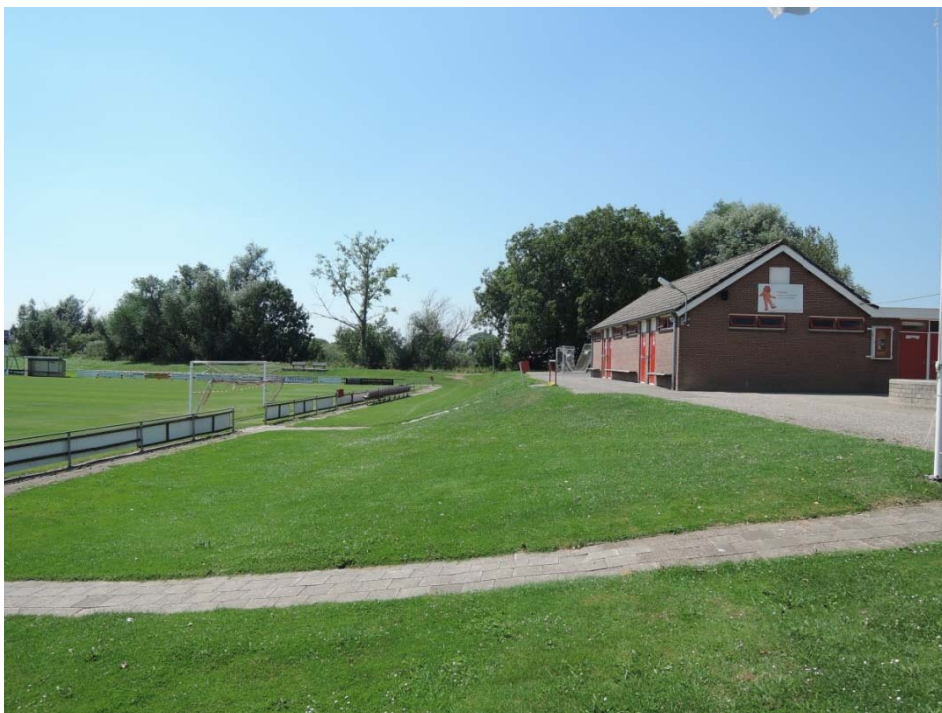
Figuur 9. Kleedkamer-gebouw Voetbalvereniging Brakel
