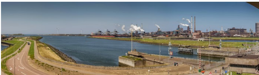
Figuur 2.4.1 Sluis IJmuiden [bron: Harry van Reken, fotografie Sydney Bulham, 8 juli 2013, beeldbank RWS]
