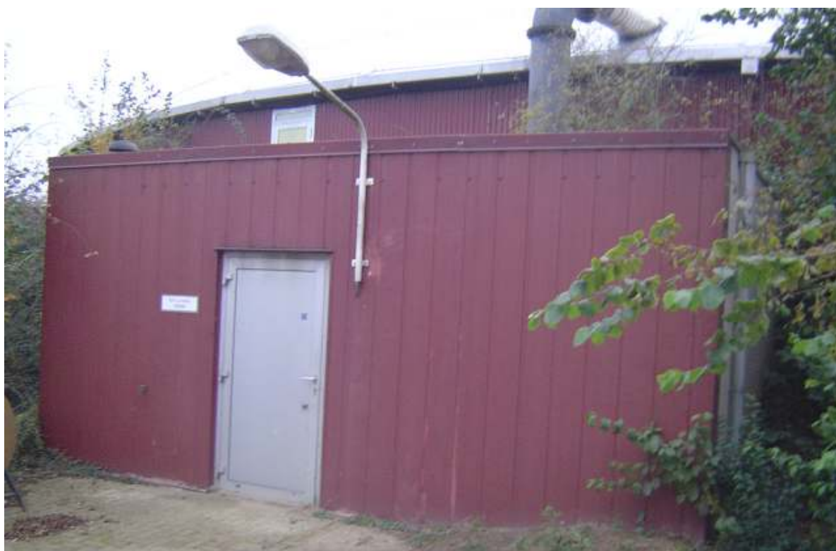
Voorbezinktank deur ventilatorgebouw
