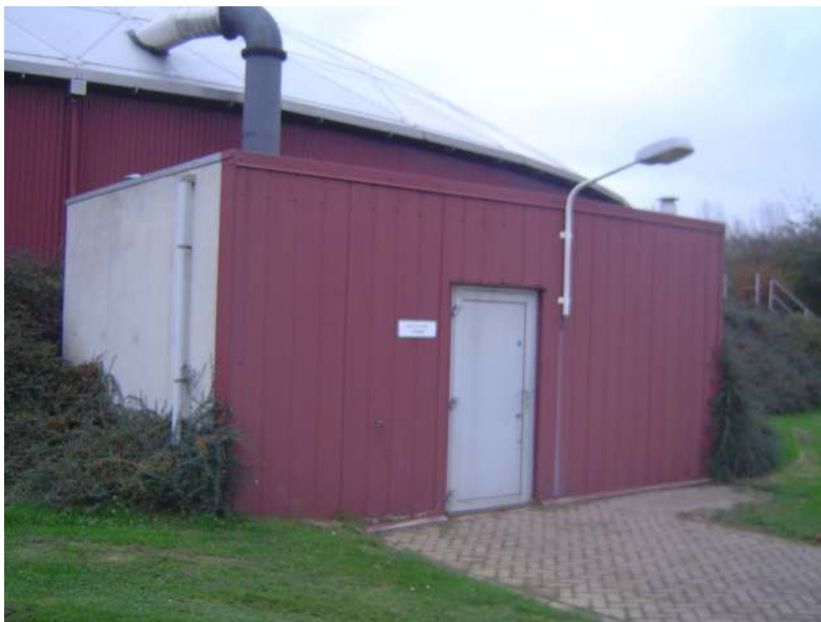
Voorbezinktank deur ventilatorgebouw
