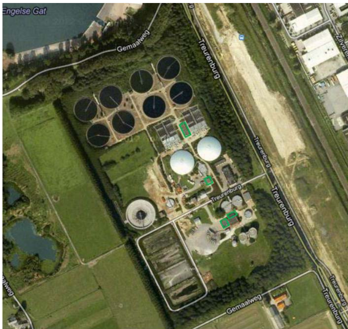
Figuur 1 Groen omkaderde gebouwen zijn mogelijk geschikt, omdat deze kleine gaten en kieren bevatten. Hierdoor voorzien zij mogelijk in vaste paar- en verblijfplaatsen voor vleermuizen
