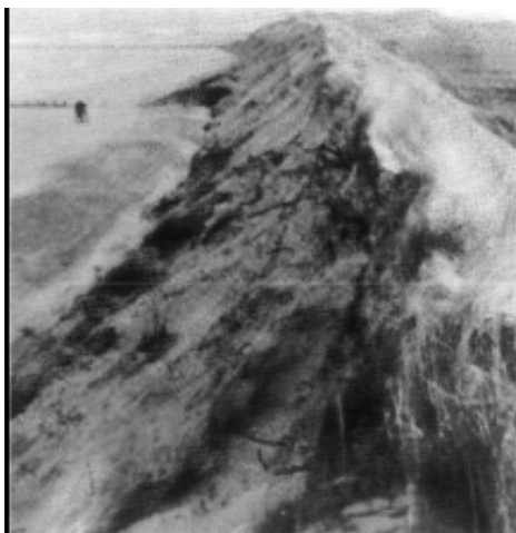
Figuur 2.4: Weggeslagen duinvoet tussen de strandhoofden 3 en 4 aan het Noorderstrand bij de storm van 30 december 1904; uit Wilderom (1964)
