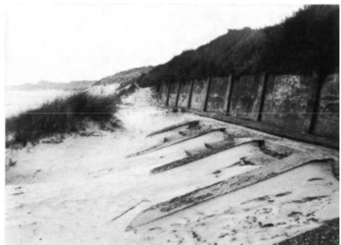
Figuur 2.5: Duinvoetverdediging en Muraltmuur in de duinwaterkering het Noorderstrand; uit Wilderom (1964)
