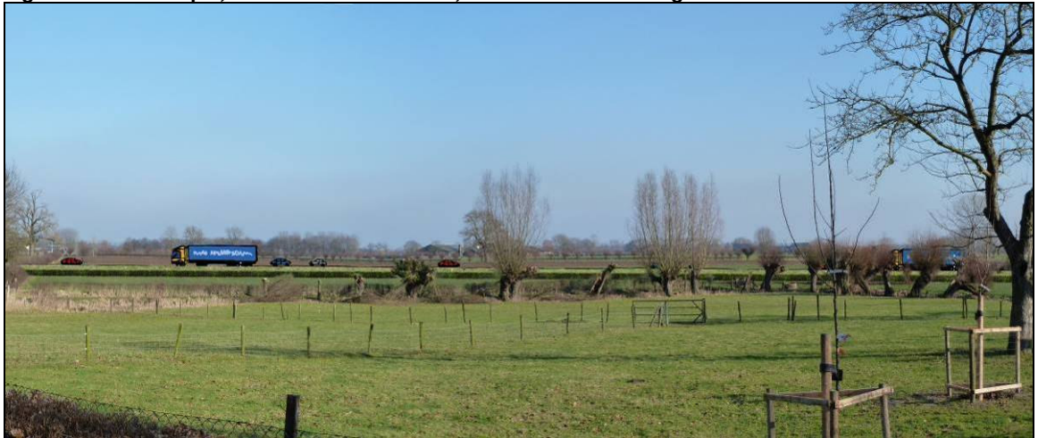
Figuur 4.15: N345 op 1,5 meter boven maaiveld, voorzien van een haag aan de voet van het talud
