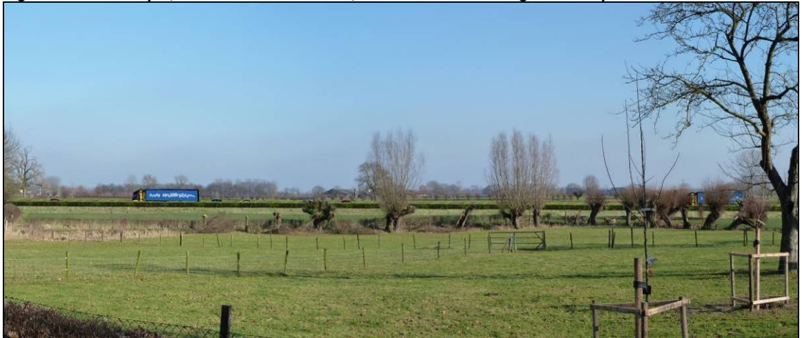
Figuur 4.16: N345 op 1,5 meter boven maaiveld, voorzien van een haag aan de top van het talud
