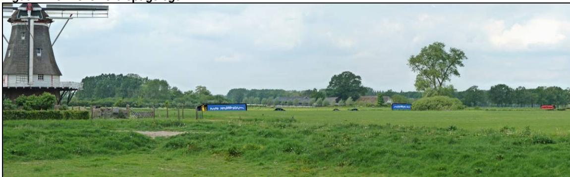
Figuur 4.28: N345 verdiept gelegen
