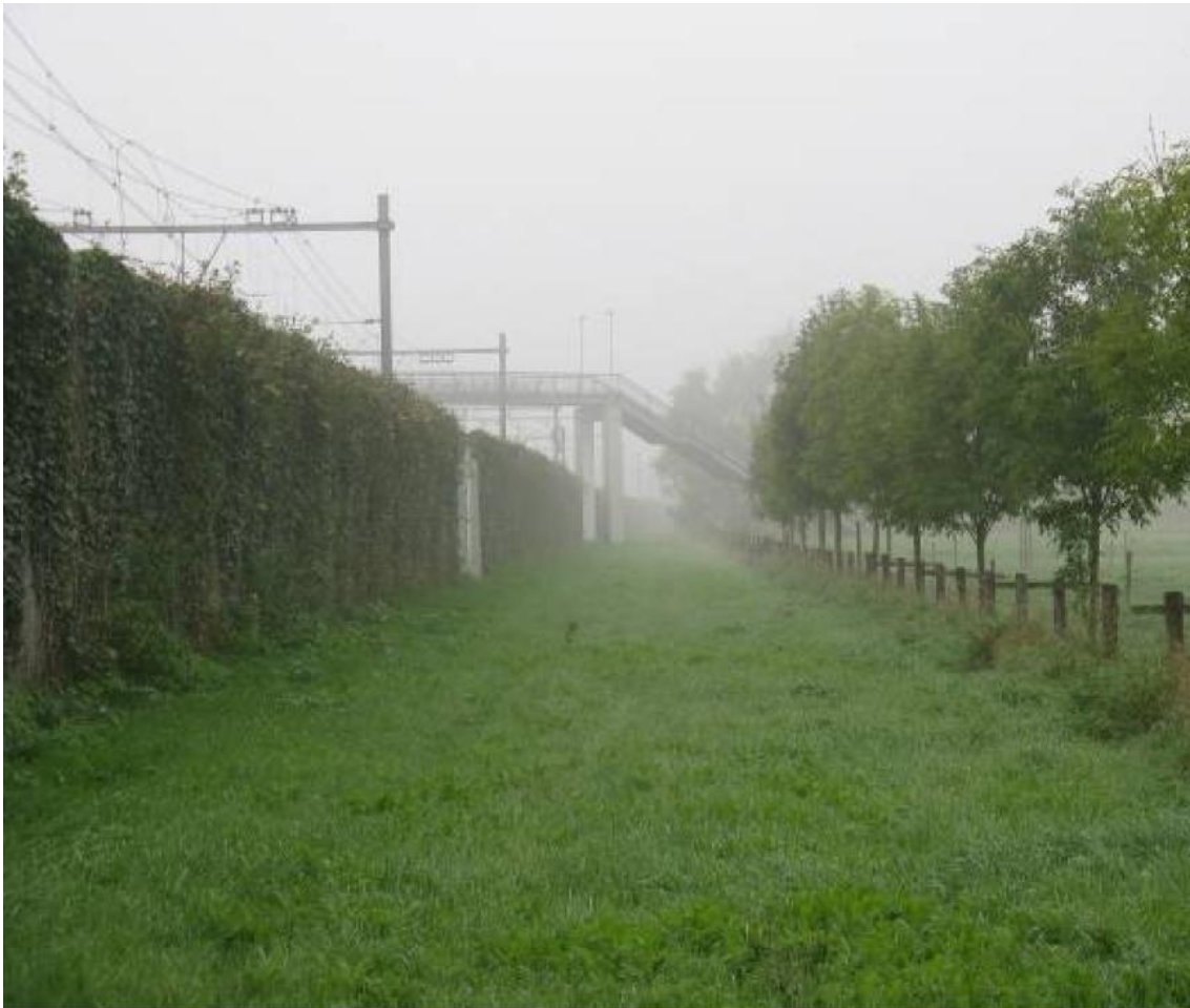
Afbeelding 23 Geluidschermen beplant met klimplanten
