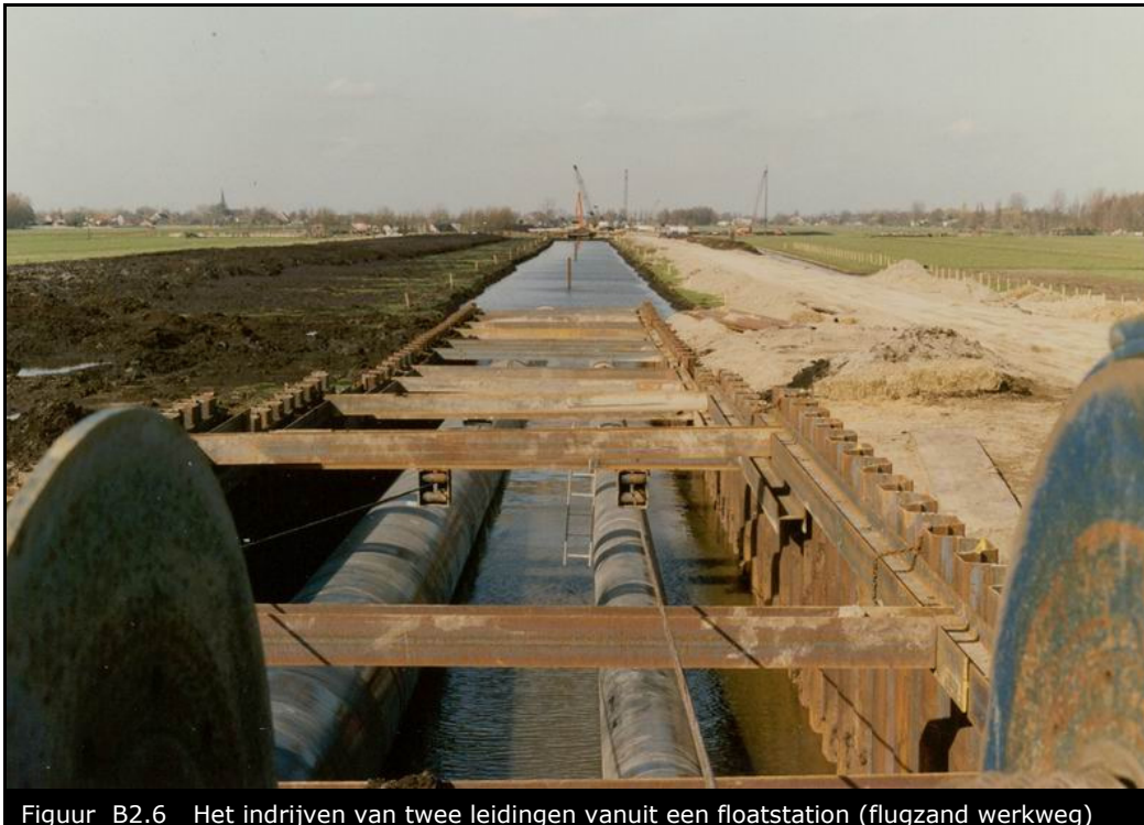
Figuur B2.6 Het indrijven van twee leidingen vanuit een floatstation (flugzand werkweg)
