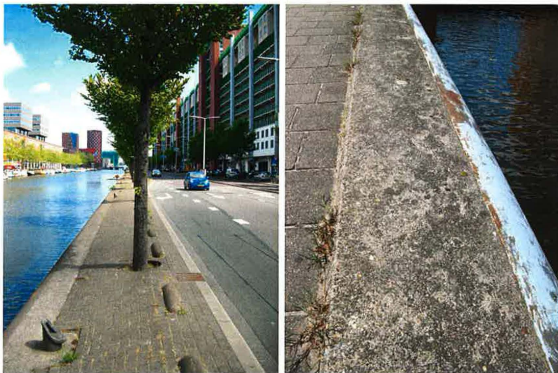
Figuur 6.3 De bestaande kade en kaderand
