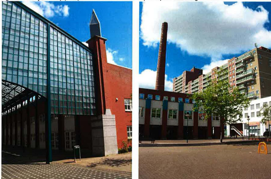
Figuur 5.7 Gietijzeren kap (links) en schoorsteen ketelhuis (rechts) van voormalig Slachthuis
