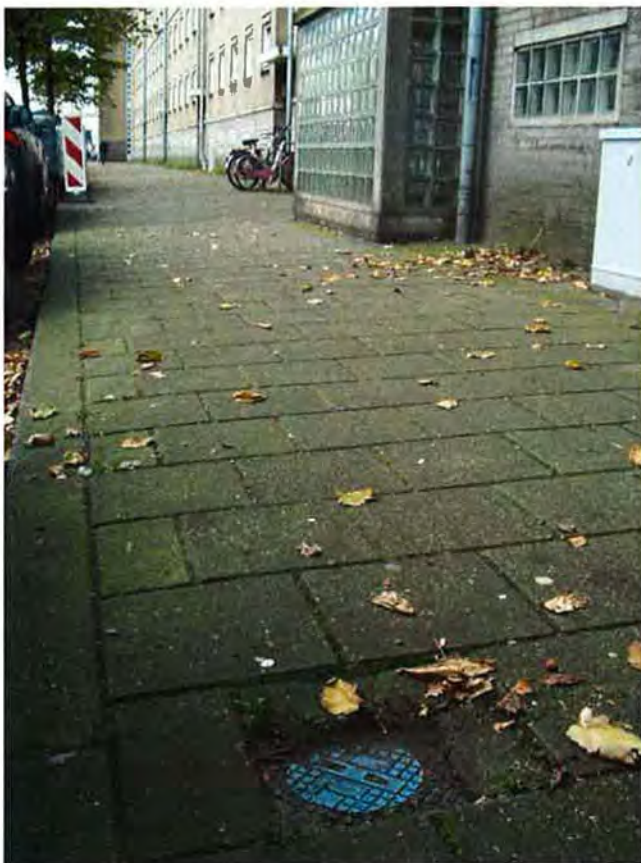
Een van de Peilbuizen bij complex Hagemeyer
