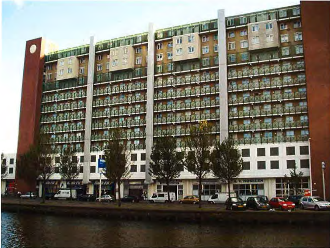
Deel van flatgebouw 'de lamel', met op begane grond bedrijven.
