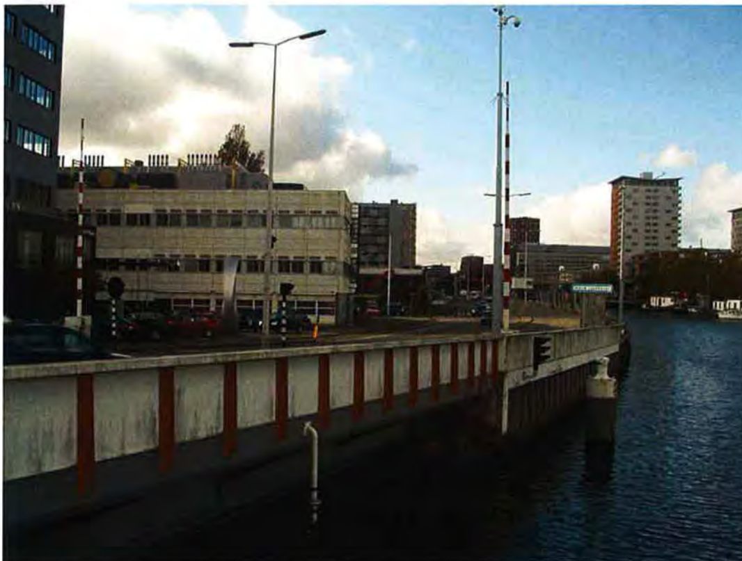
Neherkade gezien vanaf Trekvlietbrug. Het witte gebouw is Neherkade 1k
