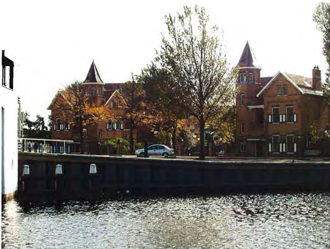
Portierswoningen Slachthuisstraat 1 en 3 en beschoeiing Neherkade
