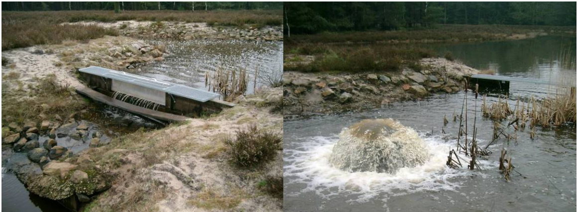
Foto links: Uitstroming in grote infiltratievijver, met op de achtergrond de kleine infiltratievijver, Foto rechts: Stuw tussen beide vijvers. (Foto's Baukje Dijkstra, DHV)
