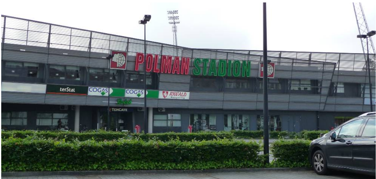
Figuur 1.1 Het huidige Polman Stadion
