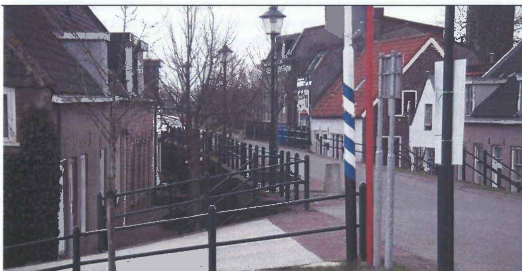
Figuur 5.14 Keermuur Everdingen (bron: Tauw)
