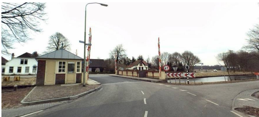
Brug over de Drentse Hoofdvaart te Norgerbrug (bron: CycloMedia)
