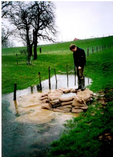
Figuur 2-4 Gevolgen van zandmeevoerende kwel (Lekdijk Jaarsveld)
