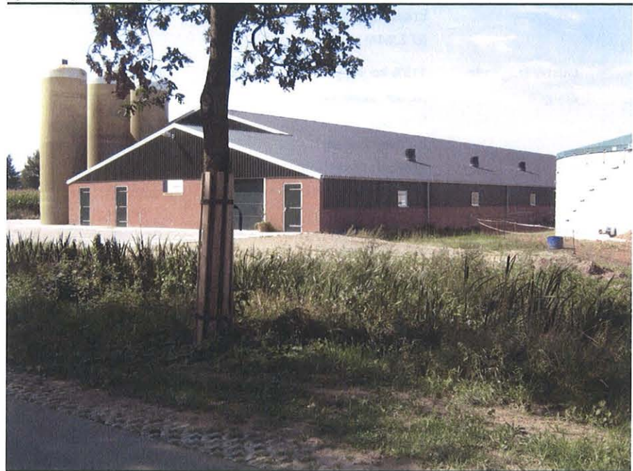
Afbeelding 2: Reeds opgerichte stal aan de Steenakkerstraat
