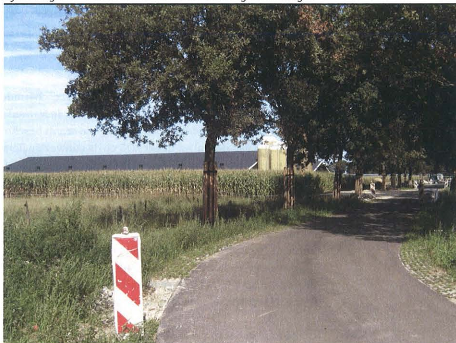
Afbeelding 15: De Steenakkerstraat verbreed met grasbetontegels
