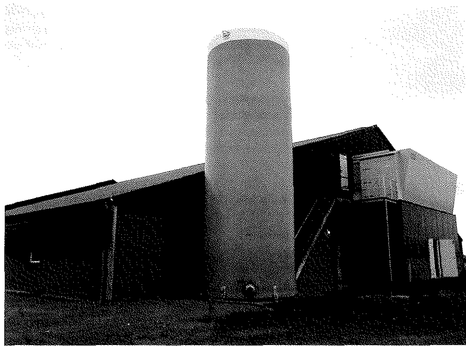
Afbeelding 6: Voorbeeld van een vleesvarkensstal, in dit geval met luchtwasser
