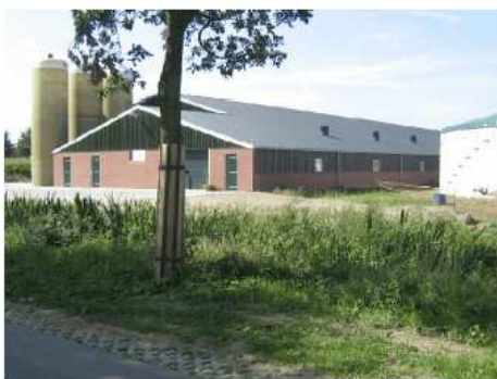
Figuur 5: Reeds aanwezige stal van het bedrijf van de familie De Haas aan de Steenakkerstraat 19.
