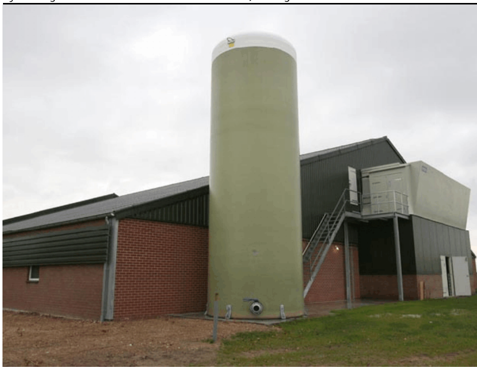
Afbeelding 6: Voorbeeld van een vleesvarkensstal, in dit geval met luchtwasser
