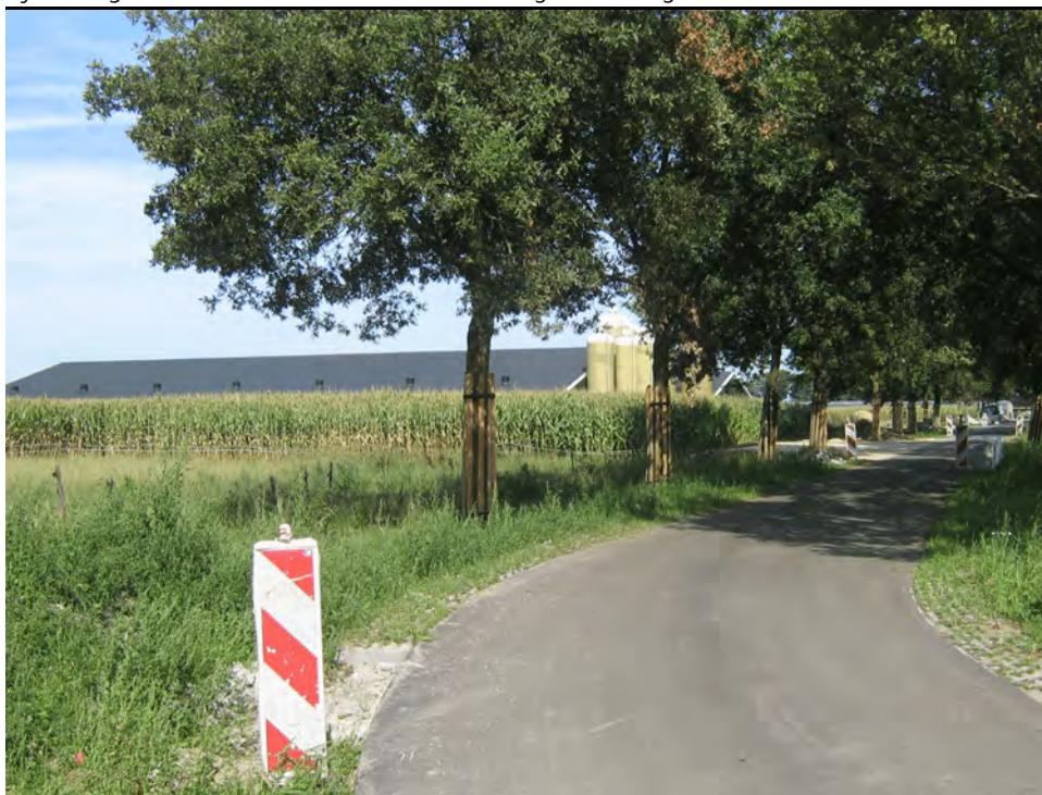
Afbeelding 8: De Steenakkerstraat verbreed met grasbetontegels
