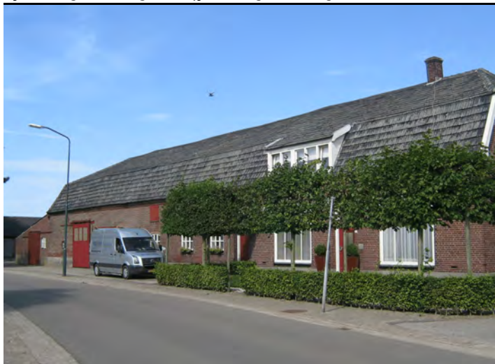
Afbeelding 4: Huidige bedrijfswoning met aangebouwde stal
