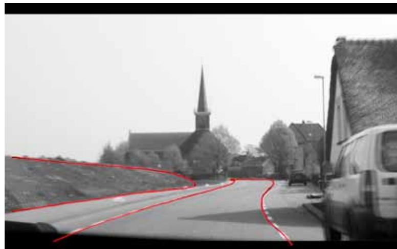
Begin dubbele dijk bij Nieuw-Lekkerland. Weg en dijk splitsen zich.
