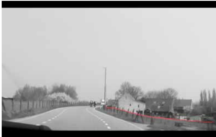
Bebouwing aan de dijk is naar achteren toe uitgegroeid. De (oude) berm is op een natuurlijke manier onderdeel van de dijk.
