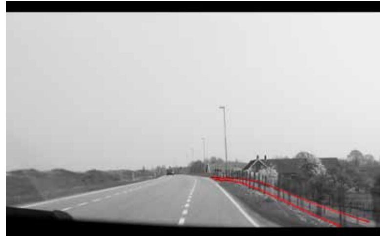
Nieuwe oprit parallel aan de dijk.
