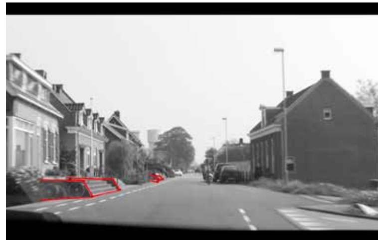
Buitendijkse woningen hoogwatervrij met eigen opgang. Trappetjes aan de openbare weg geven inzicht in situatie.
