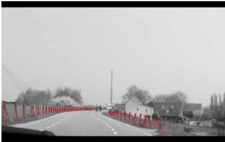
Kruin wordt aan beide zijden begrensd door privegebruik. Erfafscheiding op de insteek.
