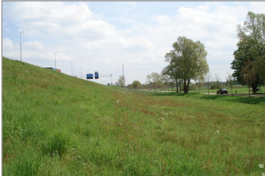
Foto 1. Glooiend bermtalud aan de zuidzijde van de A1, situatie 2010 (foto L. Leusink).
