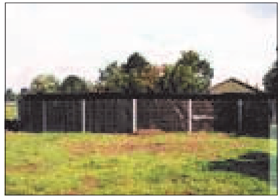
Een tussenvorm van silo en bassin, uitgevoerd met kunststof wanden. Kleine capaciteit, bij erf, zonder landschappelijke beplanting. Zichtbaar op korte afstand vanaf de weg.
