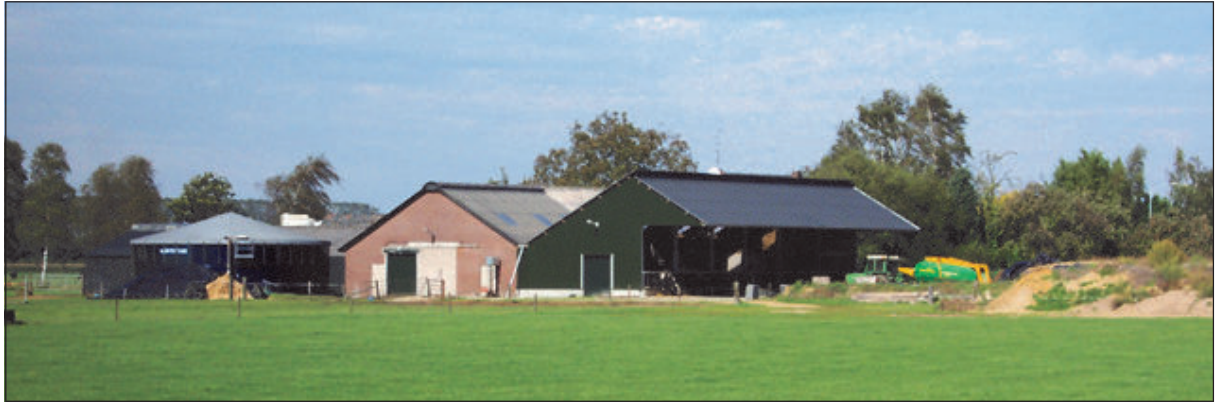
Een mestilo uitgevoerd in metaal en kunststof, met passende kleurstelling. Kleine capaciteit, bij erf, zichtbaar vanuit het land.
