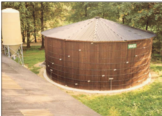
Een mestilo uitgevoerd in hout op een betonnen fundering. Kleine capaciteit, bij erf. Zichtbaar op korte afstand vanaf de weg.
