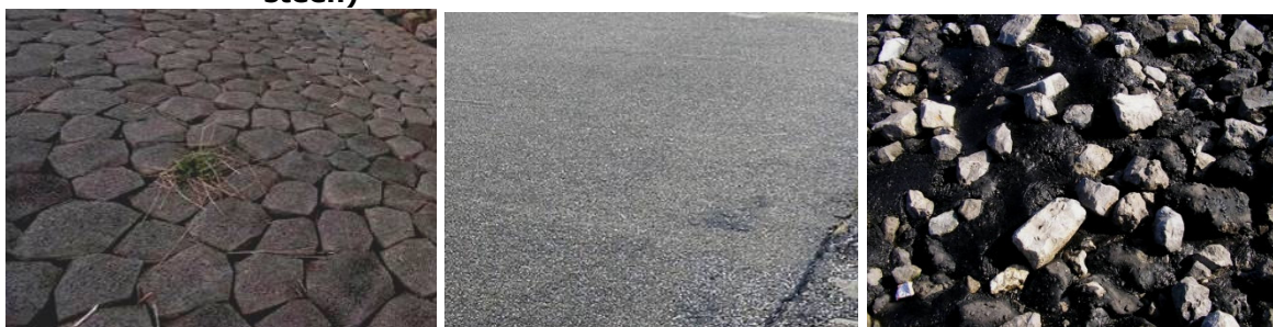
Afbeelding 1.8. Bekledingsvarianten (v.l.n.r. betonzuilen, asfalt, gepenetreerde breuksteen)
