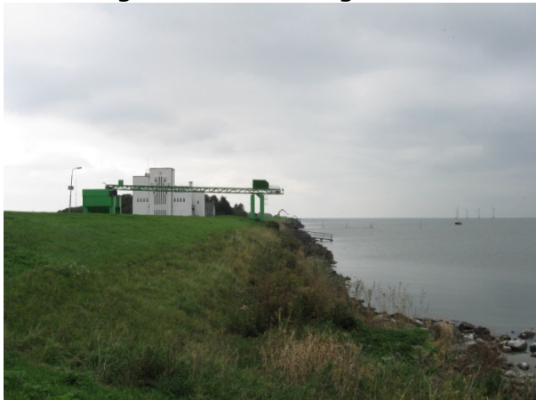
a) Juist ten zuiden van gemaal Lely (km 0,2) is een vaste zandoverslag van de Vries & van der Wiel aanwezig.
