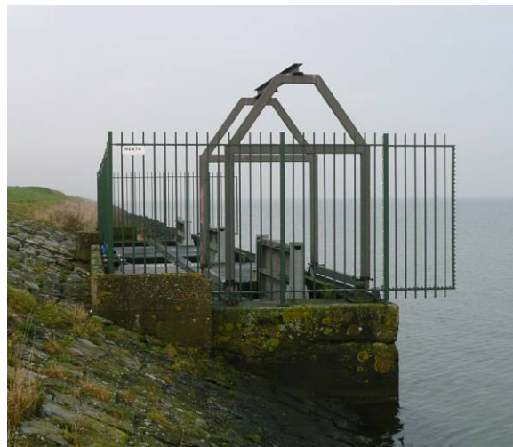
b) Constructie van gemaal Lely in het buitentalud
