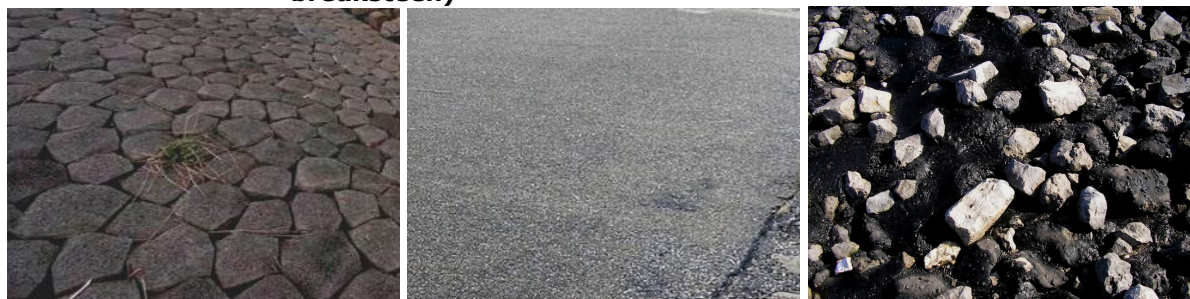
afbeelding 2.2. Bekledingsvarianten (v.l.n.r. betonzuilen, asfalt, gepenetreerde breuksteen)
