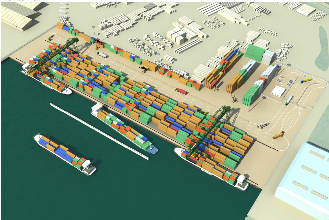
Figuur 9 Artist impression ingekaste langskade en inrichting CT
